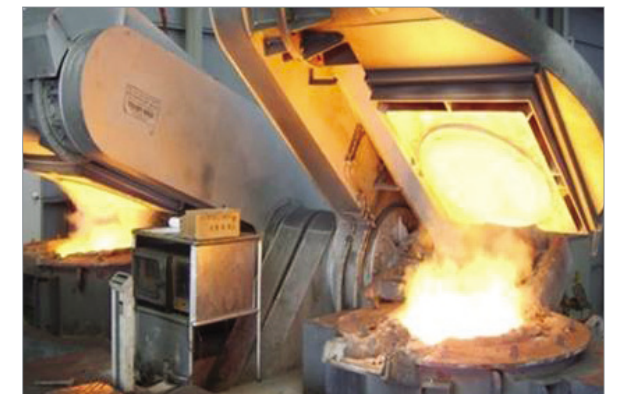
고주파 유도로 (3500KW - 5TON DUAL)
