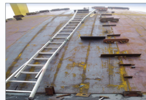
DORM ROOF 가조립
